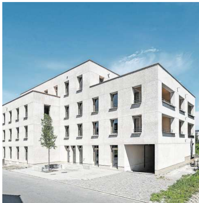
Der Holzsystembau ist mit Hanfbeton gedämmt. Bild: Openly, Jens Ellensohn
